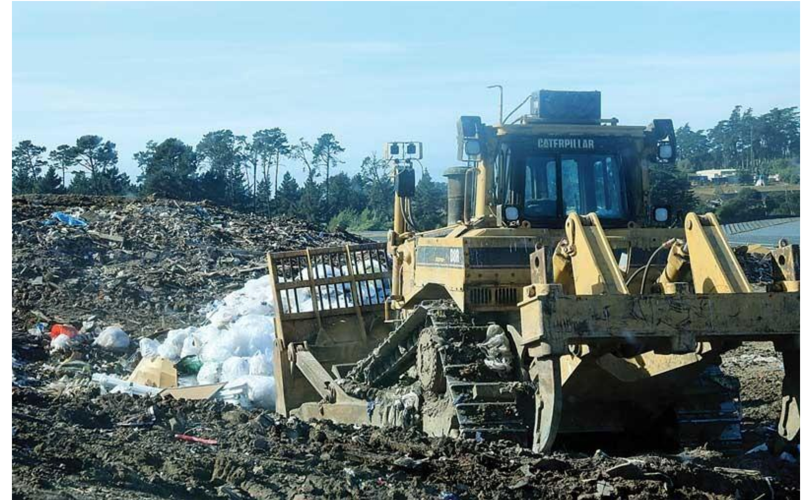
Buena Vista Landfill
